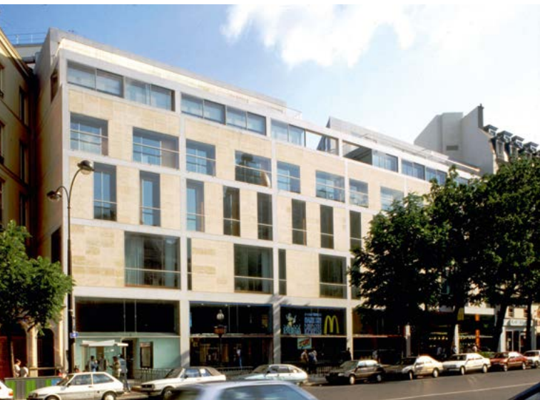
Boulevard des Italiens, à Paris. Maître d'ouvrage : AGF. Mission : conception et détails d'exécution de la façade © D&A
